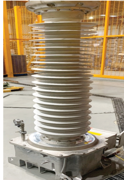
Figura 1. Vederea generală a transformatorului
